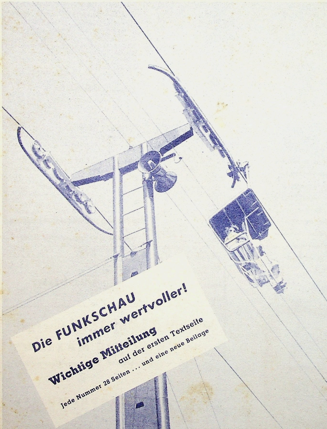
Auf der Deutschen Gartenschau 1950, Stuttgart, errichtete Siemens eine Lautsprecheranlage, deren Lautsprecher an den Masten der Sesselbahn befestigt waren, um die Fahrgäste bei etwaigen gelegentlichen Störungen zu beruhigen. Die gesamte 800 m lange Fahrstrecke konnte mit nur vier Lautsprechern und einem 25-Watt-Verstärker einwandfrei mit Schall versorgt werden. (Aufnahme: Siemens & Halske - Wieland)
